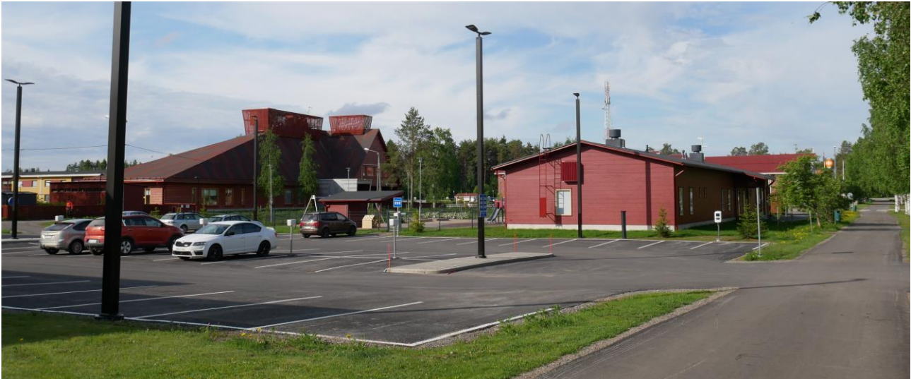
Kaupungintalon eteläpuolella sijaitsevat uudet päiväkotirakennukset.
