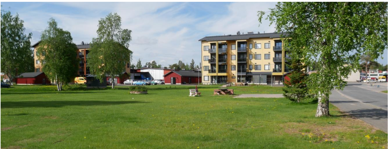
Kaupungintalon länsipuolelle rakentuneita uusia nelikerroksisia asuin- ja liikerakennuksia.
