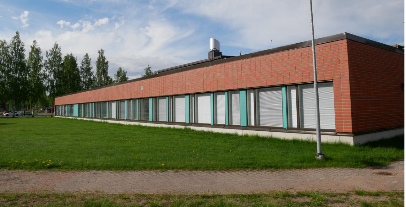
Rakennuksen julkisivua jäsentävät päädyistä päättyyn ulottuvat nauhaikkunat.
