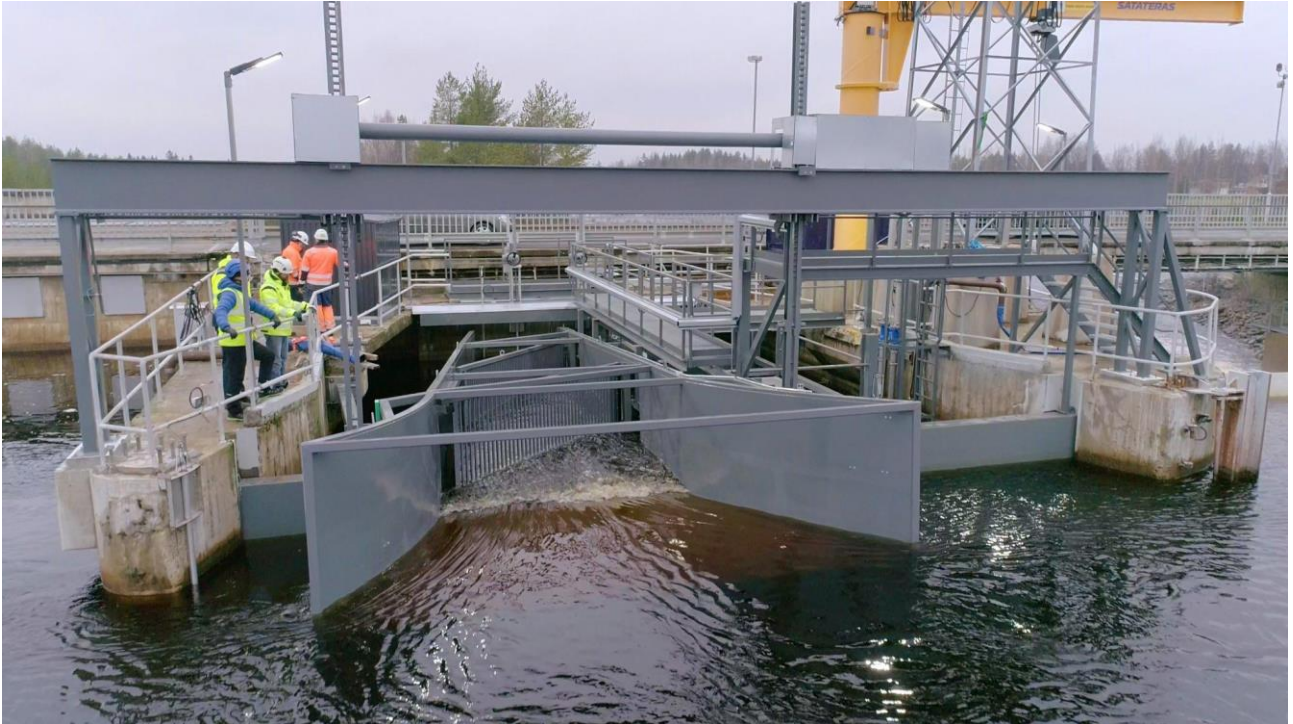
Oulun Yli-Iin Haapakosken voimalaitospadon alasvaellusrakenne ja kiinniottolaitteet. Kuva: Pohjois-Pohjanmaan liitto.
