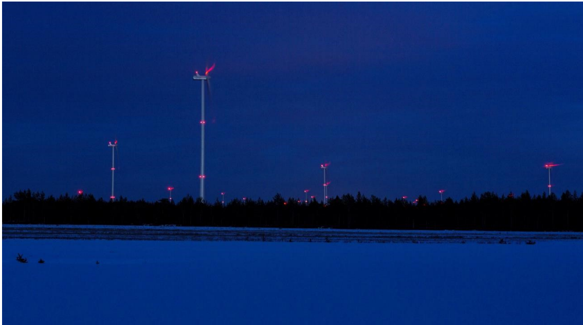
Kuva 110. Kiinteät punaiset lentoestevalot pimeällä. (Kuva: FCG)
