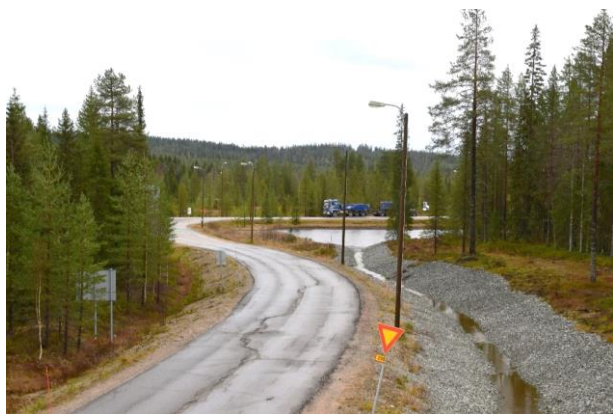
Kuva. Kuva Syötetietä kohti maantietä 862 (Syötekyläntie). Uusi kiertoliittymän paikka tie- ja katusuunnitelman mukaan tulee olemaan kuvassa näkyvän sorayhdistelmän kohdalla. Kuvassa näkyvä huleveden viivästysallas siirretään. Kävely- ja pyörätien linjaus noudattaa vanhaa Syötetien linjausta.
