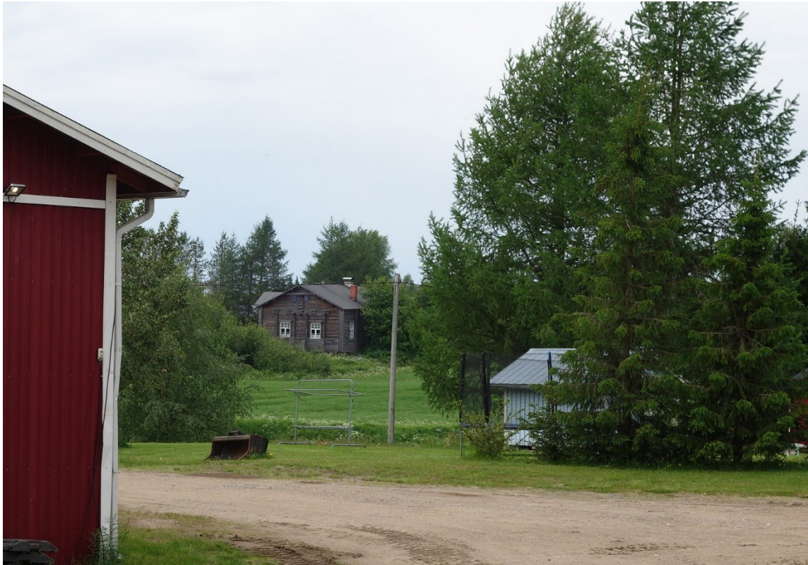
Kuva 22. Toinen Nurmiharjun päärakennuksista Livojoen itäpuolelta nähtynä. (Kuva: Riikka Ger 2021).
