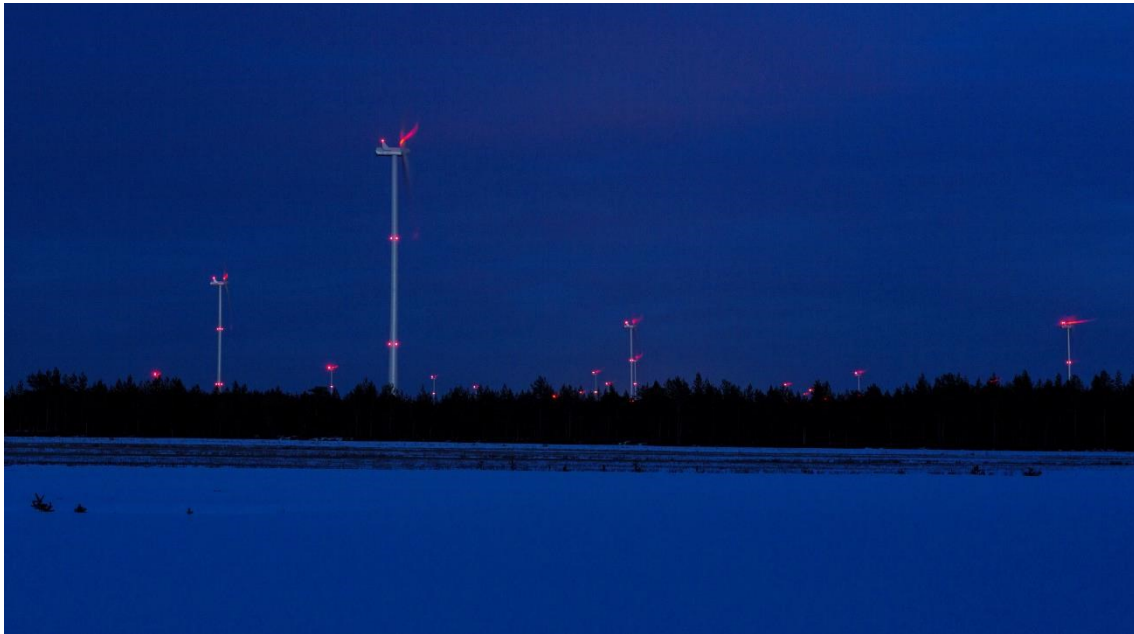
Kuva 105. Kiinteät punaiset lentoestevalot pimeällä. (Kuva: FCG)
