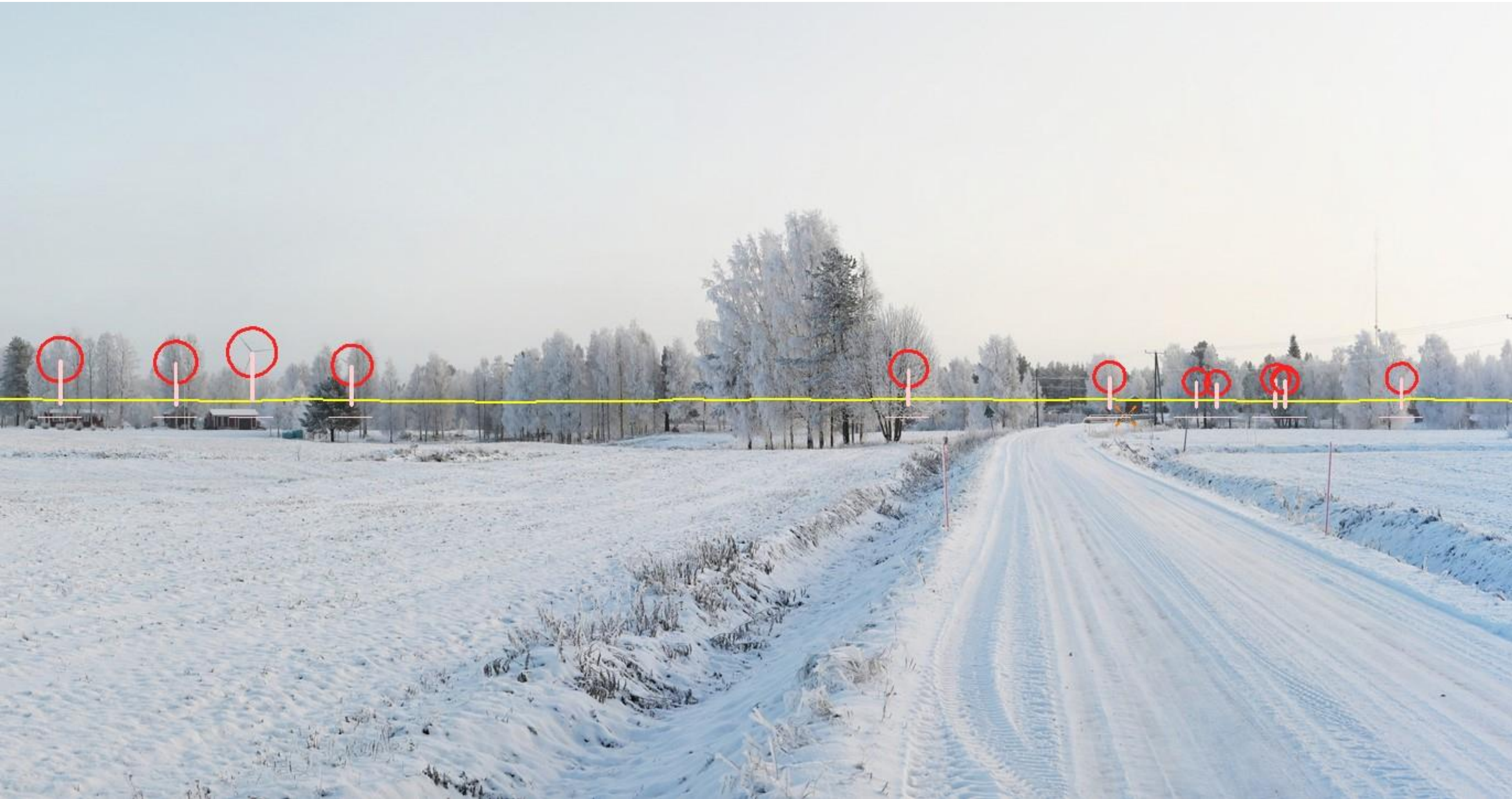
Kuva 21. Valokuvasovite kuvauspisteestä KIV02 (VE2). Kuvaa on lähennetty havainnekuvan alueelle, jossa voimaloita on näkyvissä kuvauspisteeseen. Etäisyys lähimpiin vaihtoehdon VE2 voimaloihin on noin 7,5 km. Yhteistuulen voimaloiden roottorit korostettu punaisella.
