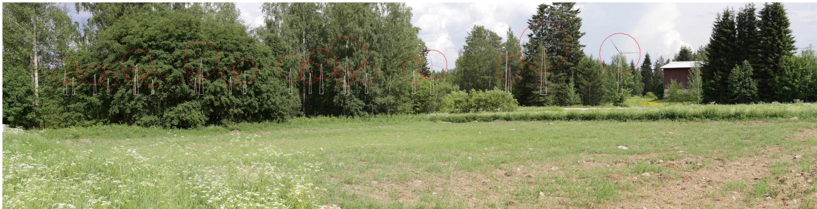
Kuva 3.2. Havainnekuva Sormusentien viereiseltä pellolta. Tuulivoimaloiden tornit on korostettu valkoisella viivalla ja lapojen pyörimisalue punaisilla ympyröillä.
