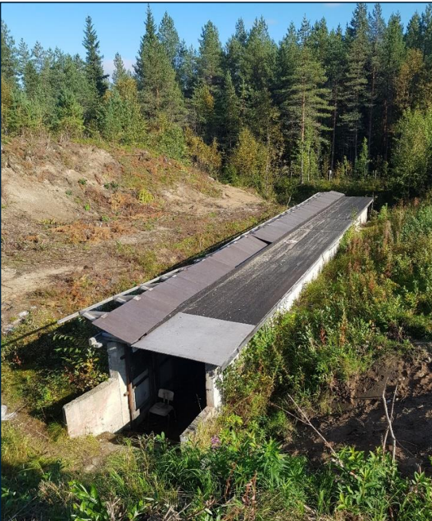
Kuva 14. Luodikkoradan betonirakenteinen näyttösuoja ja taustavallia.
