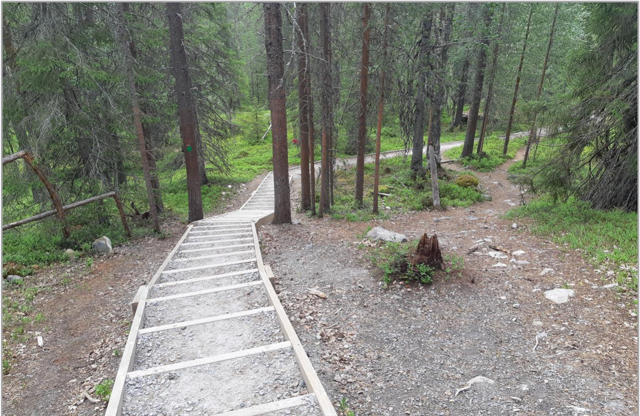
Kuva 7. Retkeilyrakenteilla ohjataan kävijöiden kulkua ja ehkäistään maaston kulumista, kuten uusien polkujen syntymistä tai jo olemassa olevien polkujen laajenemista hallitsemattomasti. Kuvan portaat ovat Rukan Valtavaaralla.
