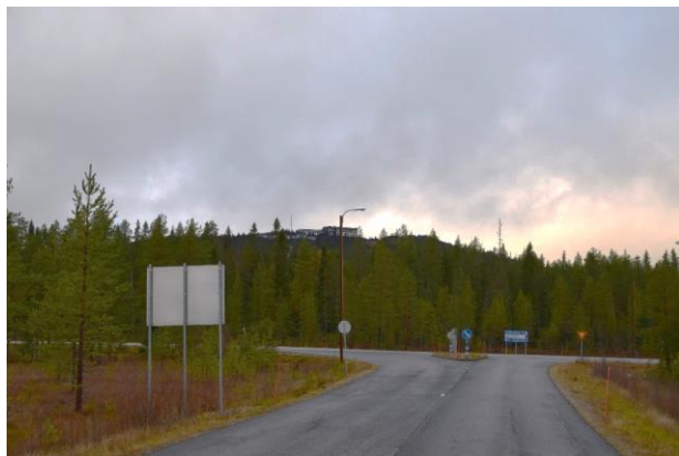
Kuva. Välihuikoselta näkymä kohti Syöteky- län tietä ja Iso-Syötteen tunturin lakea
