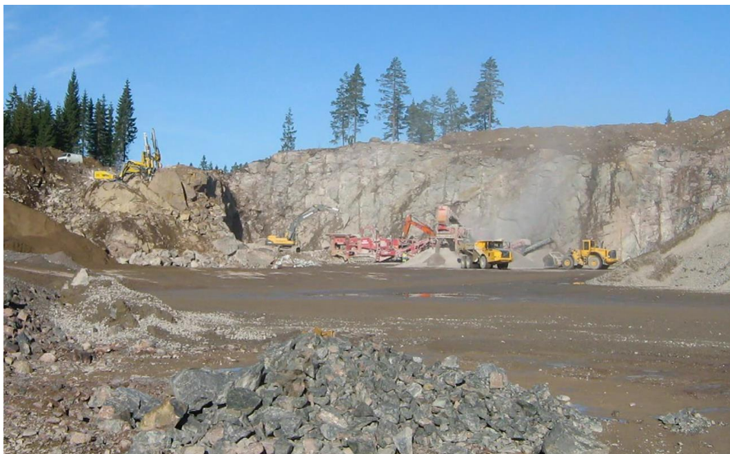
Kuva 6-1. Esimerkki kiviainesottoalueen toiminnasta. Kuvassa vasemmalla porausta, keskellä murskausta, oikealla kuljetusta ja varastointia. Kuva ©: Ympäristöministeriö 2020 / Jari Rintala.
