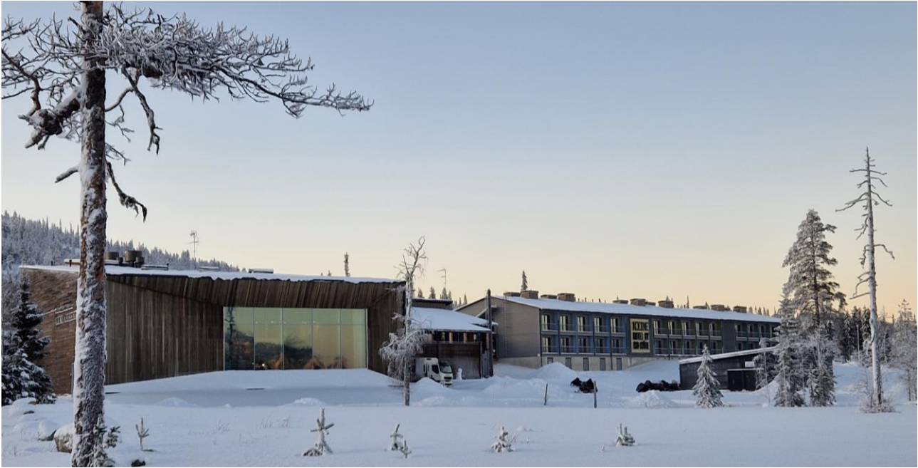
Kuva 40. LumiAreena ja Kide-Hotelli Iso-Syöteen tunturin juurella edustavat alueen uudehkoa rakentamista.
